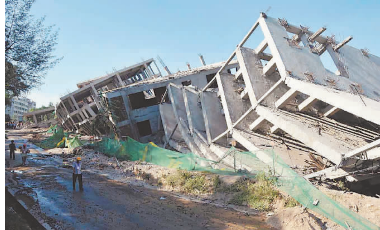
海口首次爆破拆除违法建筑
