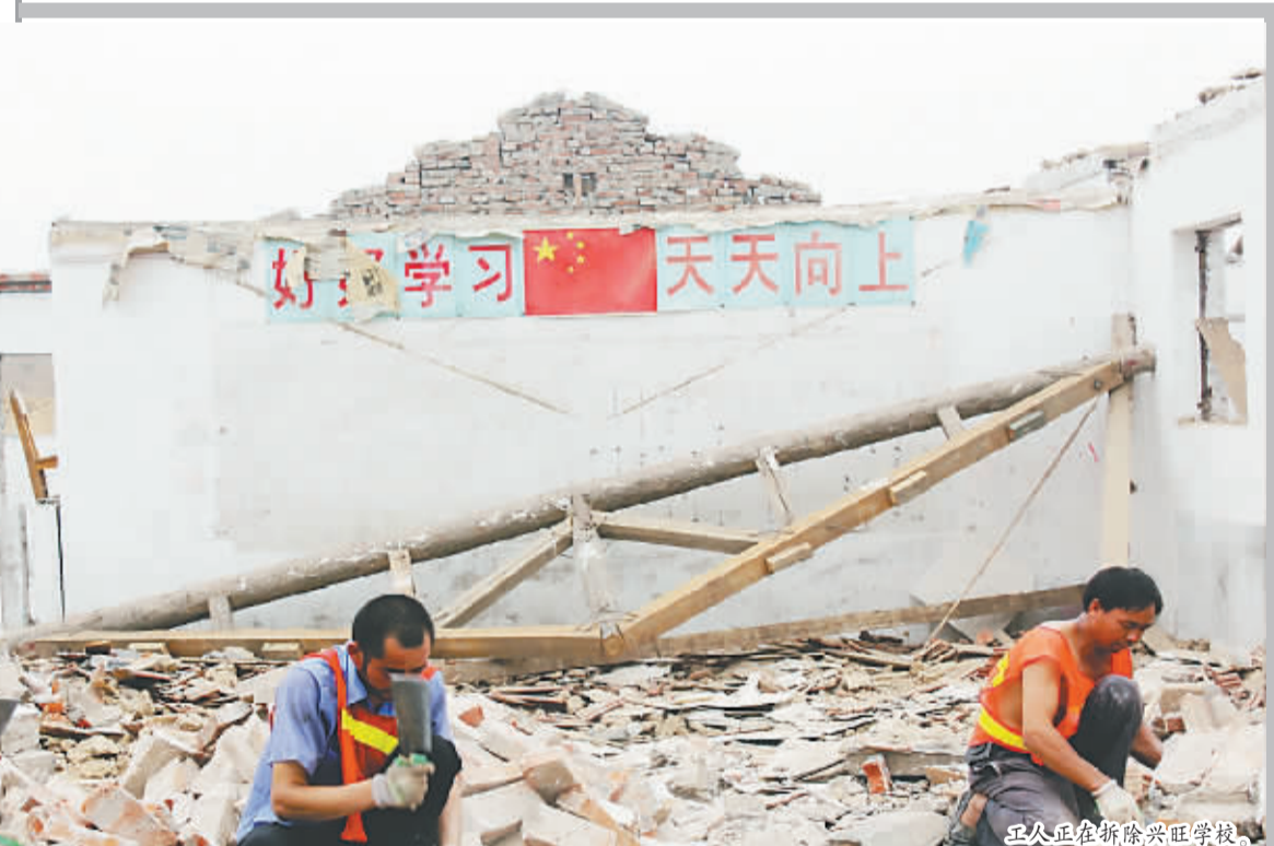
工人正在拆除兴旺学校。
