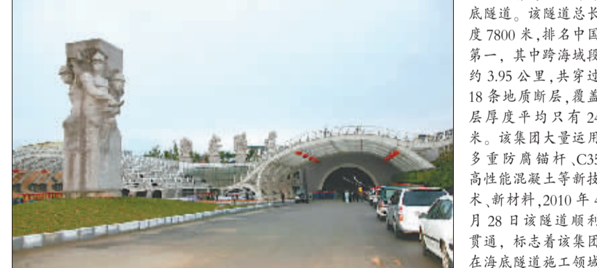
中铁十八局集团承建的厦门海底隧道
