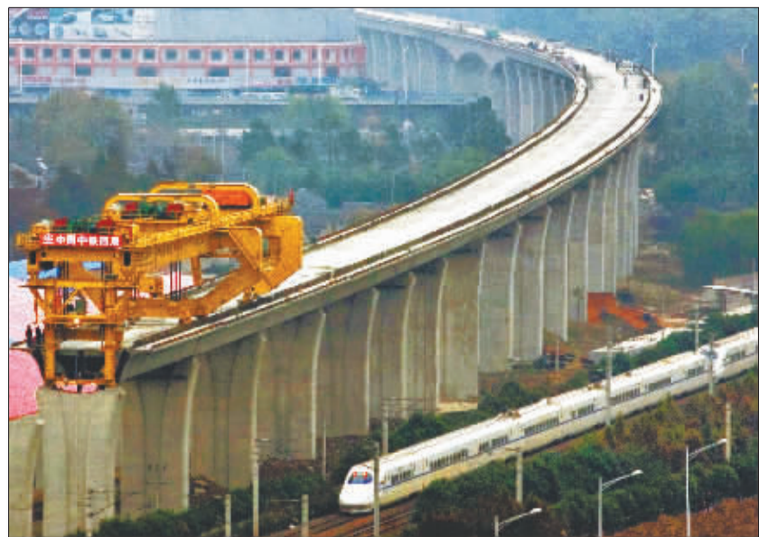
沪宁城际高铁在沪宁铁路既有线旁架梁施工 杨洪兵摄
