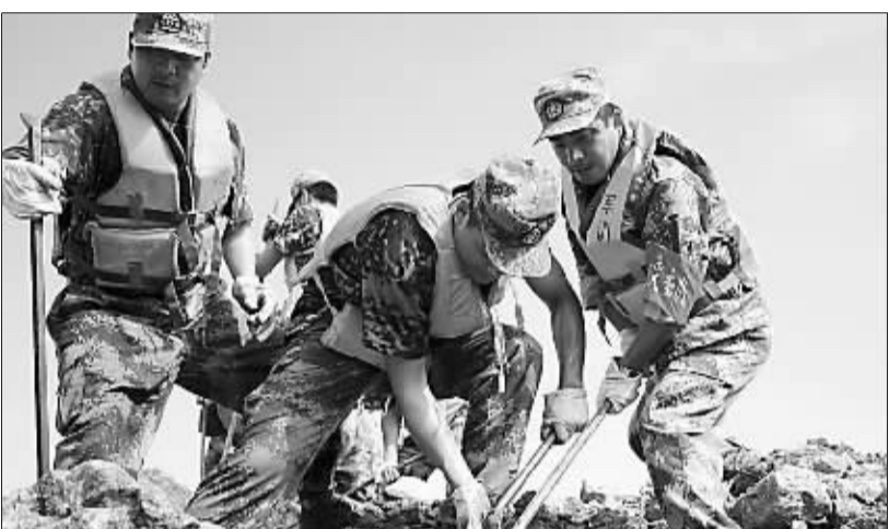
7月19日,解放军战士在出现险情水域抛石固岸。受连日高水位浸泡冲击,长江九江段江洲、棉船江岸出现崩岸险情,南京军区400名解放军官兵迅速赶往现场,在出现险情水域抛石固岸。新华社记者 周科摄
