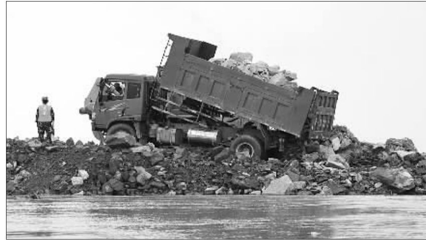
6月25日,抢险人员在唱凯决口处施工。
