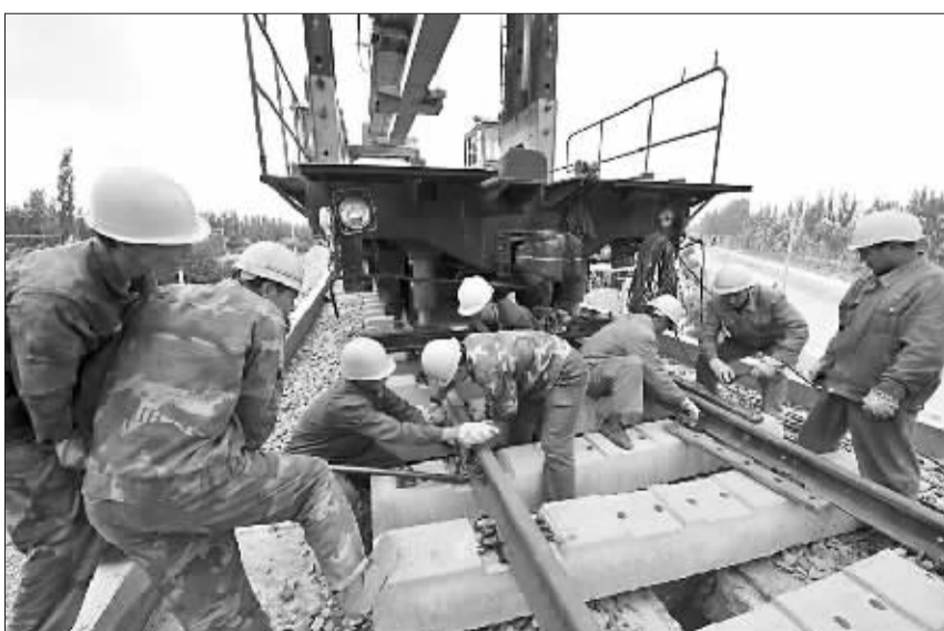
2010年6月8日,新疆喀什-和田铁路工程全线铺轨过半。金伟摄
