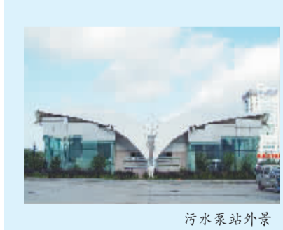
污水泵站外景
