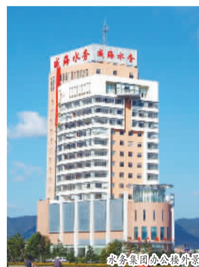
水务集团办公楼外景
