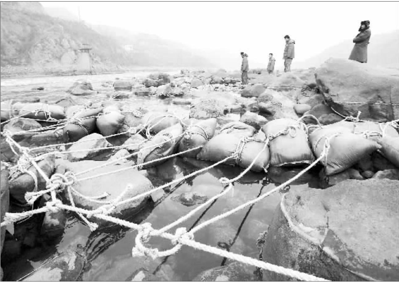
1月7日,在三门峡大坝下游约1公里处黄河河床内,抢险人员在检查由活性炭固定在水中形成的堤坝。活性炭具有吸附油污过滤河水的作用。
