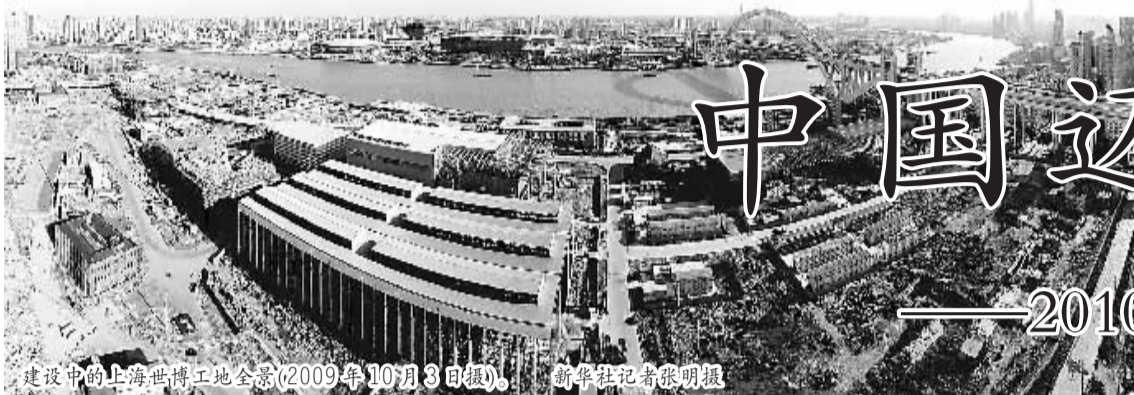
建设中的上海世博工地全景(2009年10月3日摄)。新华社记者徐明摄
