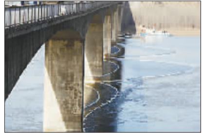
1月4日拍摄的设置在三门峡黄河公路大桥下水面的拦油带。 新华社发(张晓理 摄)
