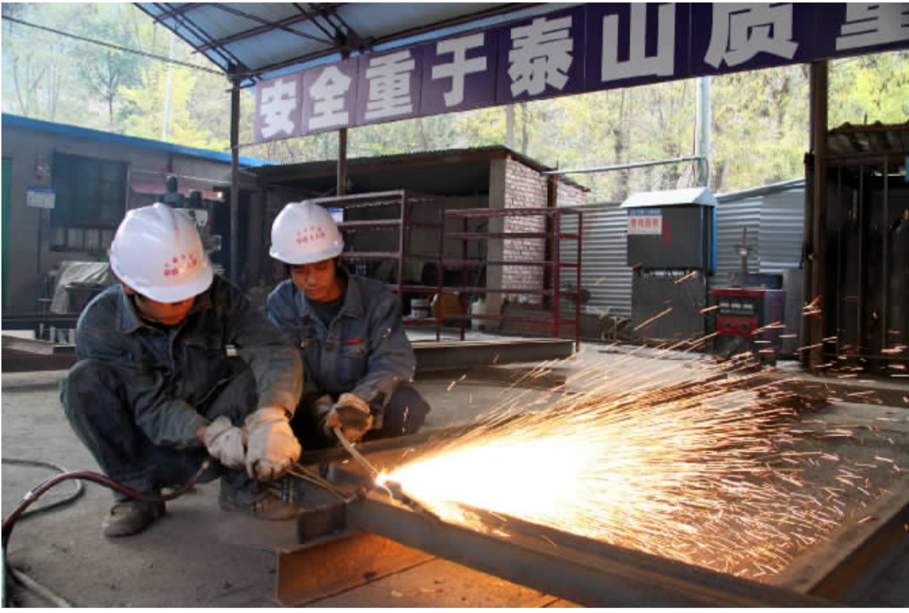
中铁十八局集团紧牵经济效益牛鼻子,向精益化管理要效益,“在有金矿的地方开矿”,截止到12月初,该集团任务承揽突破400亿元,各项经济指标创历史最好水平,实现规模与效益“齐步走”。图为集团在兰渝铁路施工中注重安全形式教育宣传,项目职工在“安全重于泰山”的标语下施工。(伍振 刘凤娟 摄)
