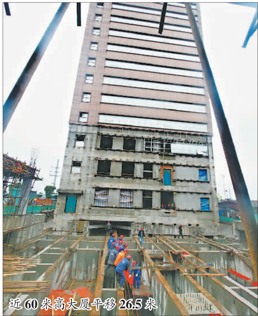
近60米高大厦平移26.5米
