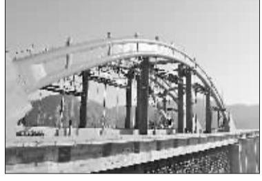
以往建桥都是下承式受力,而在太(原)中(卫)银(川)铁路线上却有一座上承式受力桥,因为桥下有8车道高速公路,建设者最终将其设计为上承式受力,而且一跨距离为82.5米。日前,这座上承式受力钢管拱桥由中铁十六局二公司顺利建成,成为陕北通道中的一道亮丽的景观。
