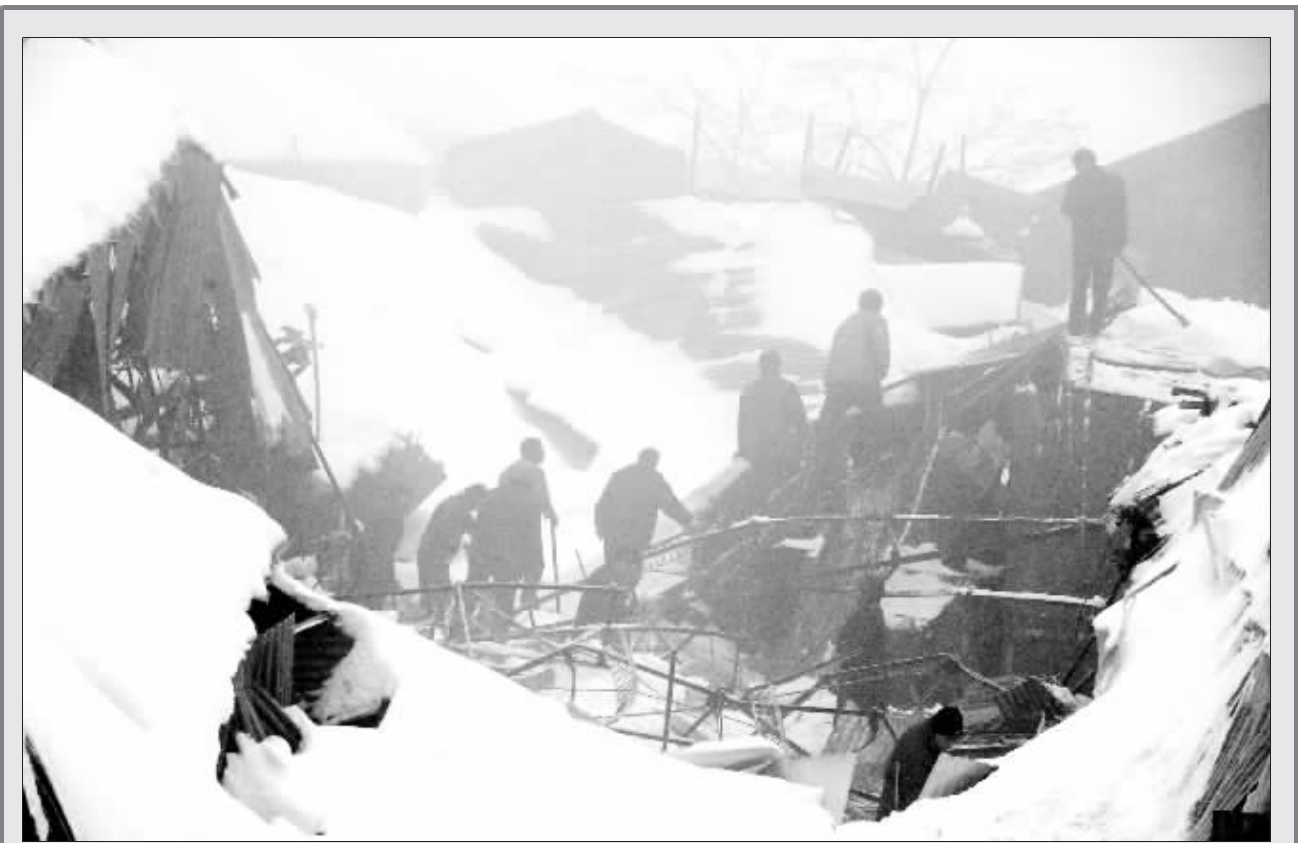
▲11月13日,河北邢台被暴雪压垮的果品市场,工人正在清理现场。连日来河北邢台遭遇的暴风雪袭击,导致11月12日凌晨2点许邢台唯一的大型果品市场被暴雪压垮,13辆运送果品汽车和500多吨货物被掩埋在雪中,所幸无人伤亡。当地政府尽快组织人员清理现场,争取早日恢复营业。
