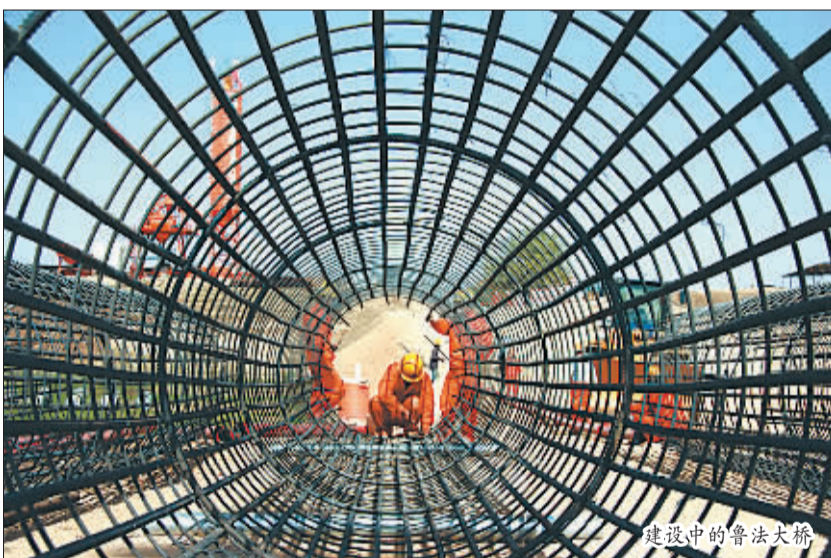
建设中的鲁法大桥
