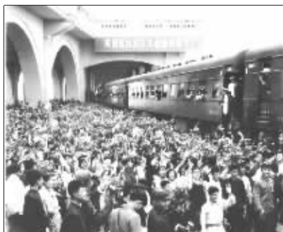
武汉长江大桥建成通车
