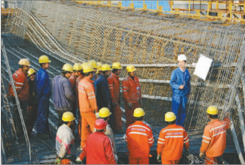
中国铁建14局宿州梁场技术人员在岗前向农民工讲解900吨箱梁钢筋整体绑扎要领。刘文摄
