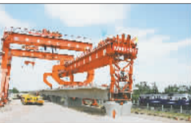
中国铁建17局集团大型架梁机在京沪高铁施工现场,右侧为京沪铁路既有线在运营中。 刘文摄
