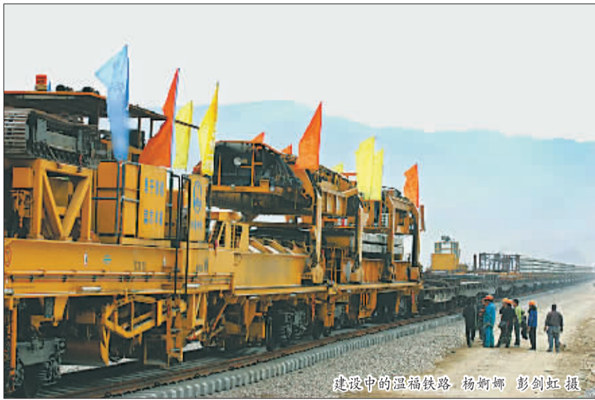
建设中的温福铁路 杨斯娜 彭剑虹 摄
