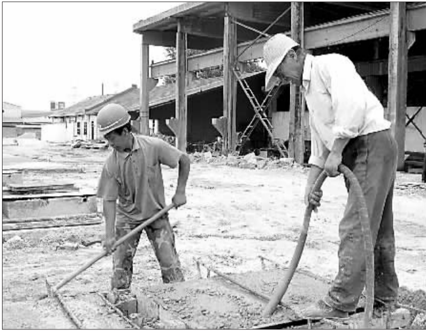
工人们正在宝汉高速公路BP15标段预制梁场工作。 李养养摄
