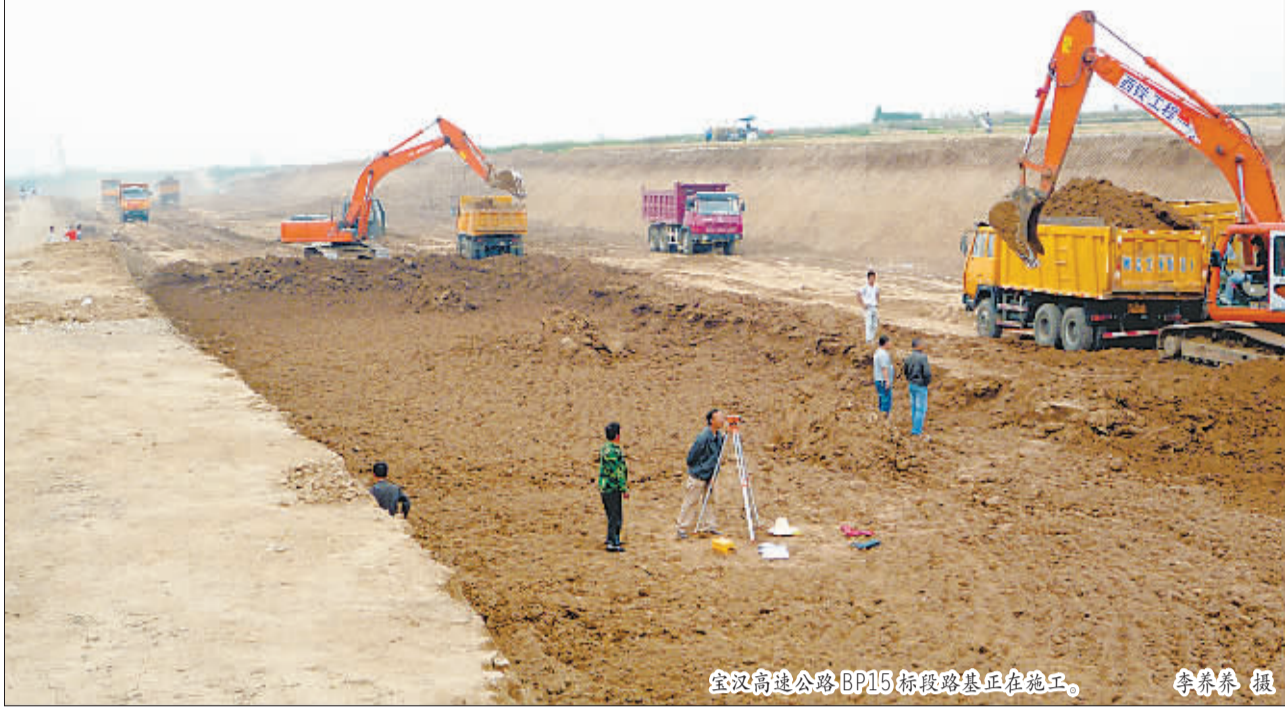
宝汉高速公路 BP15 标段路基正在施工。 李养荣 摄
