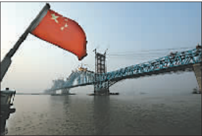
即将合龙的南京大胜关长江大桥工地。
