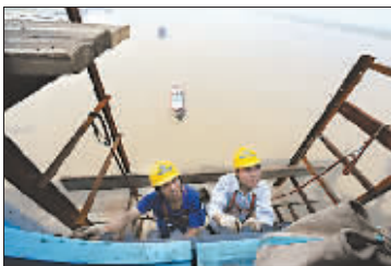
4月30日,正在安装桥梁主跨钢架的这两位职工,他们所在的施工高度为98米,他们的身后就是波涛万顷的长江江面。
