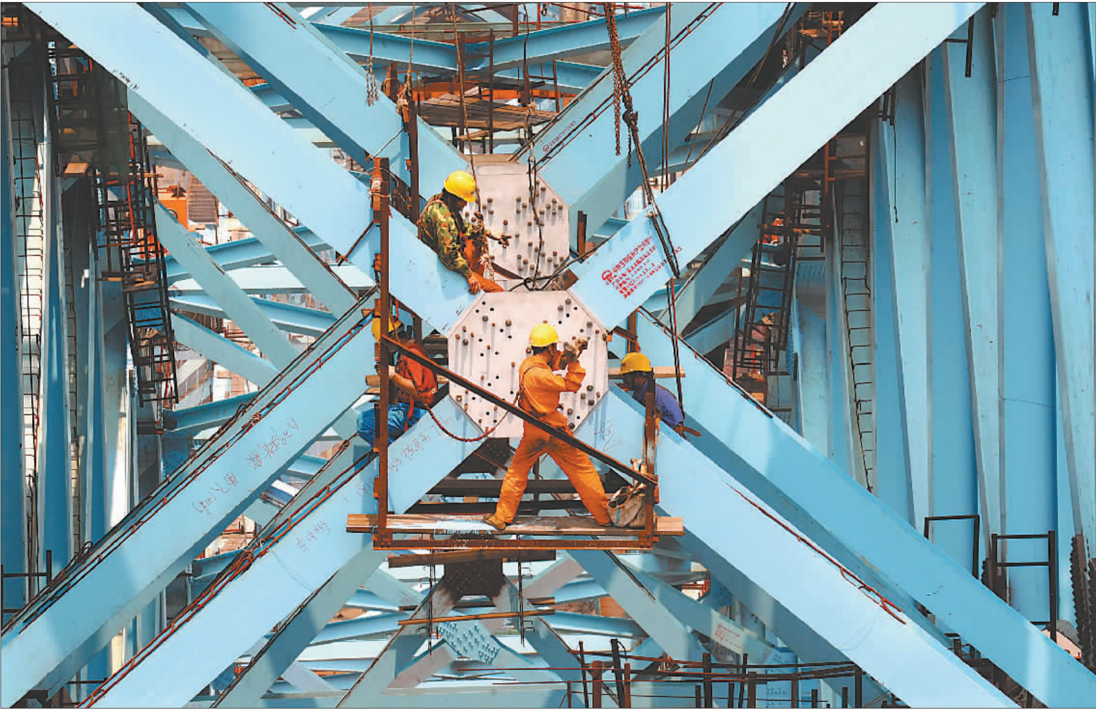
正在安装南京大胜关长江大桥最后一节桥梁主跨的中铁大桥局职工在高空作业。
