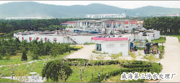
威海第三污水处理厂
