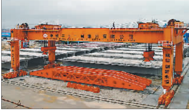
福厦铁路客专控制制梁场
