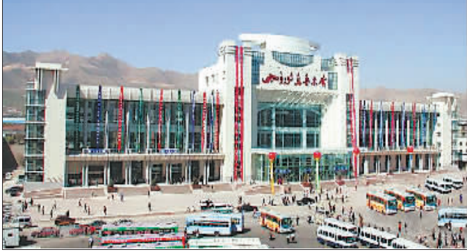
承建施工的乌鲁木齐铁路客运站房工程,获鲁班奖、国家优质工程奖
