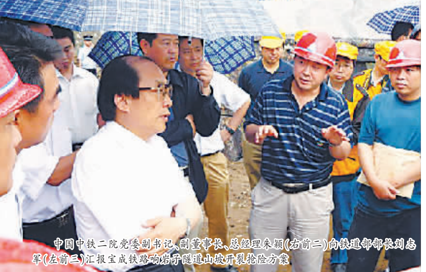
中国中铁二院党委副书记、副董事长、总经理朱颖(右前二)向铁道部部长刘志军(左前三)汇报宝成铁路响岩子隧道山崩开裂抢险方案
