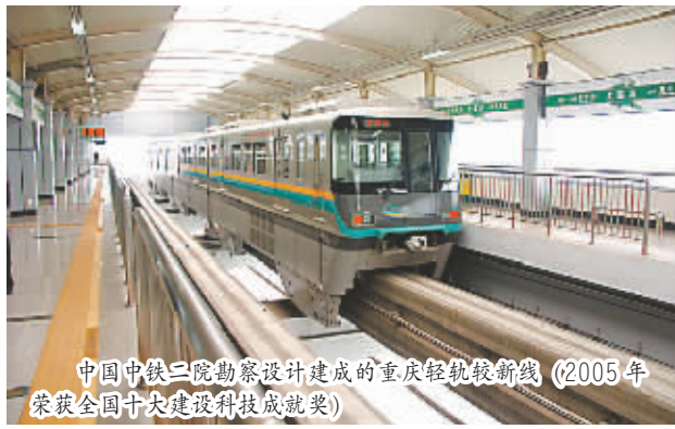
中国中铁二院勘察设计建成的重庆轻轨较新线(2005年荣获全国十大建设科技成就奖)
