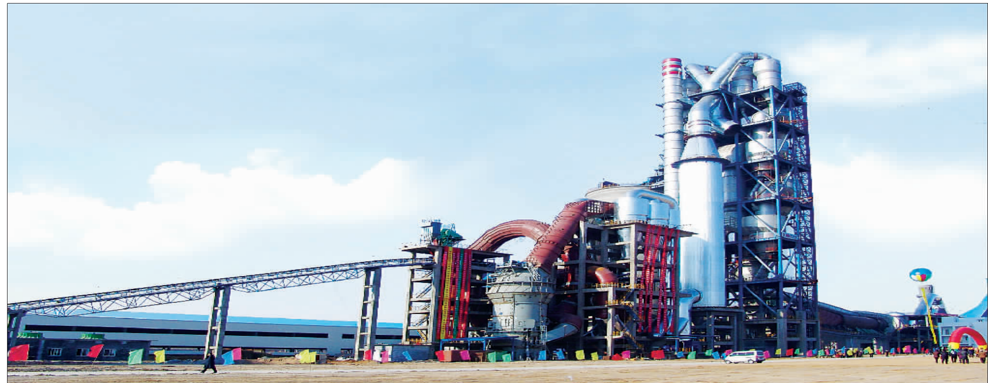
公司总承包的中联6000吨水泥生产线
