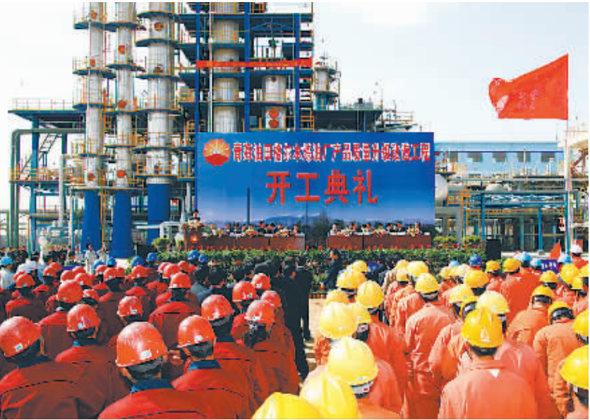
格尔木炼油厂产品质量升级改造工程施工
