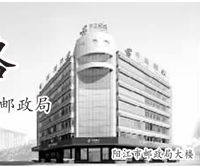
阳江市邮政局大楼
