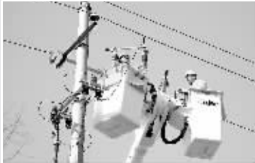
电力职工在进行带电作业
