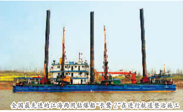
全国最先进的江海两用钻爆船“长霄2”号在进行航道整治施工
