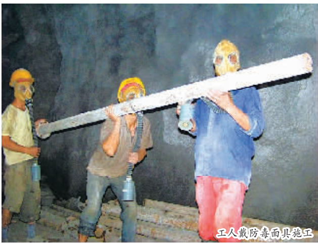
工人戴防毒面具施工
