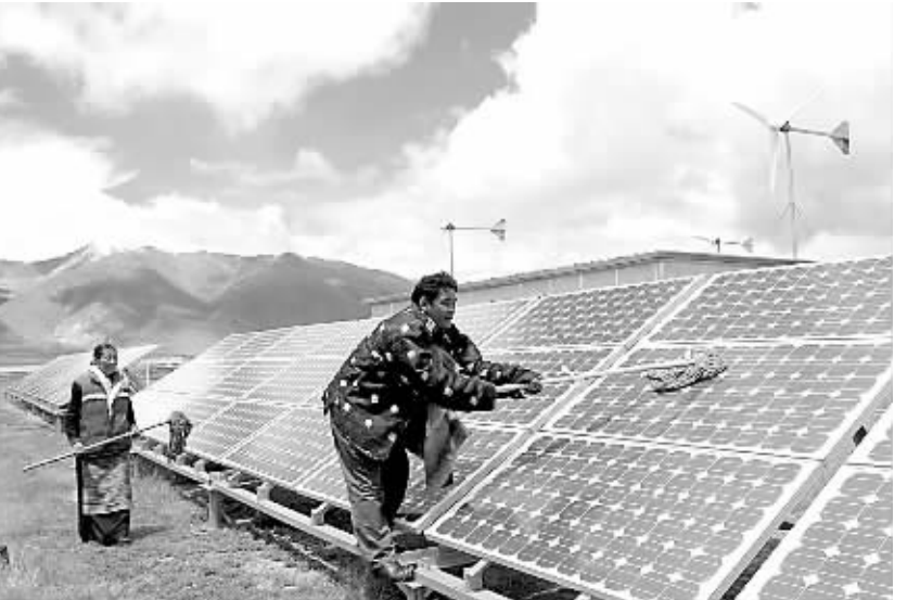
在西藏自治区那曲地区香茂乡风光互补电站,尼玛次仁正在擦拭维护光伏充电板。目前,国家投资兴建的风光互补电站遍及那曲地区多个乡,实现了乡乡通电,基本解决了当地藏民的生活用电。
