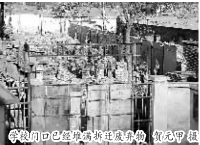
学校门口已经堆满拆迁废弃物 贺元甲 摄
