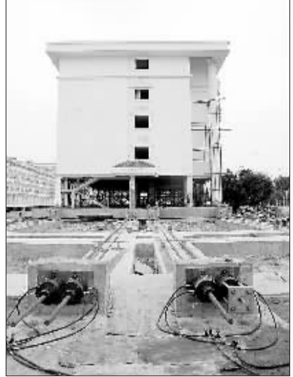
3月23日,用于大楼平移的设备已安装调试就绪。
