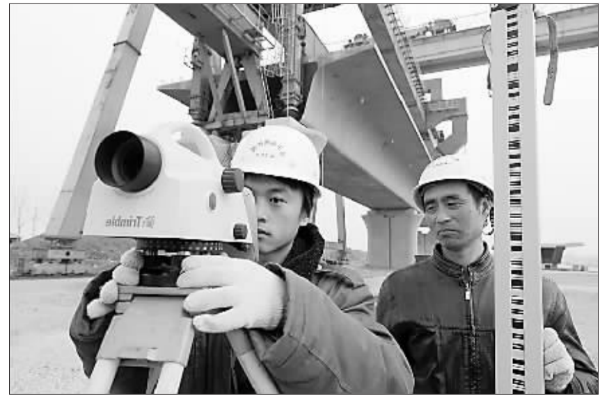
中铁十八局集团在京沪高速铁路施工中,高度重视工程测量工作,为工程提供强有力的技术保证。这是路桥公司测量人员正在进行精确测量。
