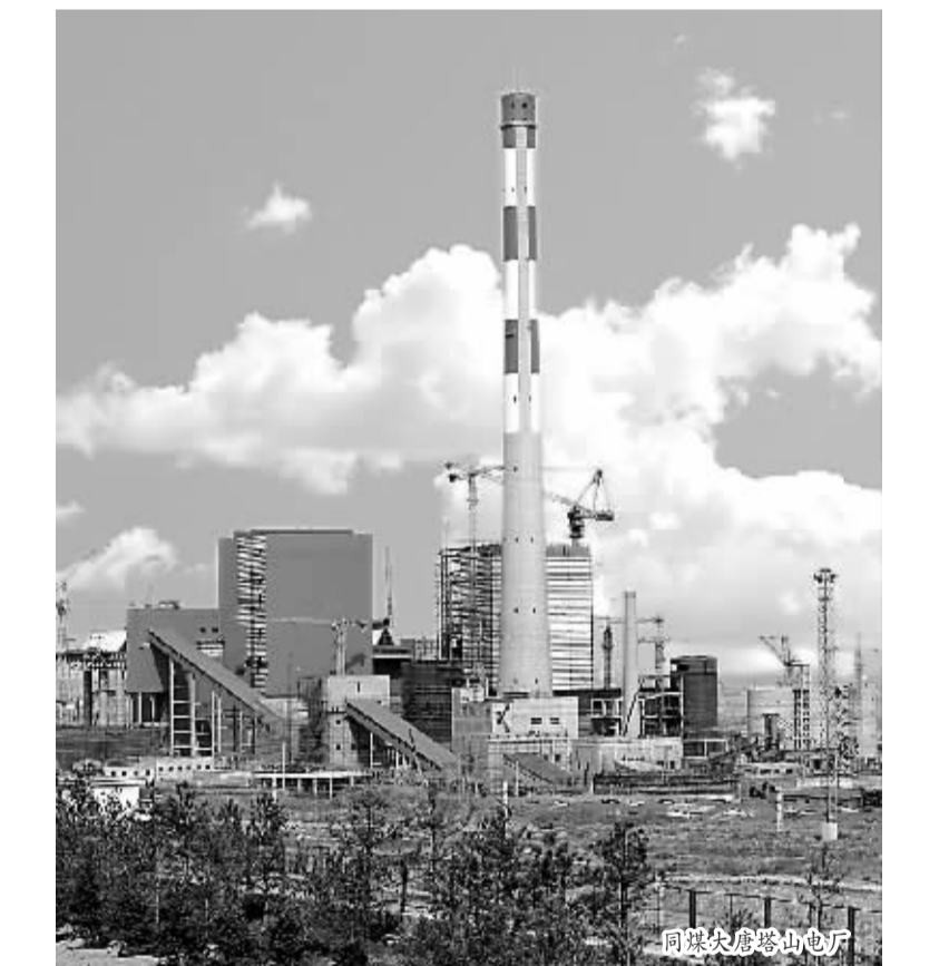
同煤集团塔山电厂
