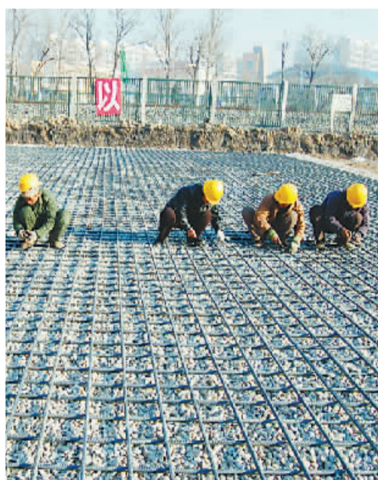
路基网格钢筋绑扎
