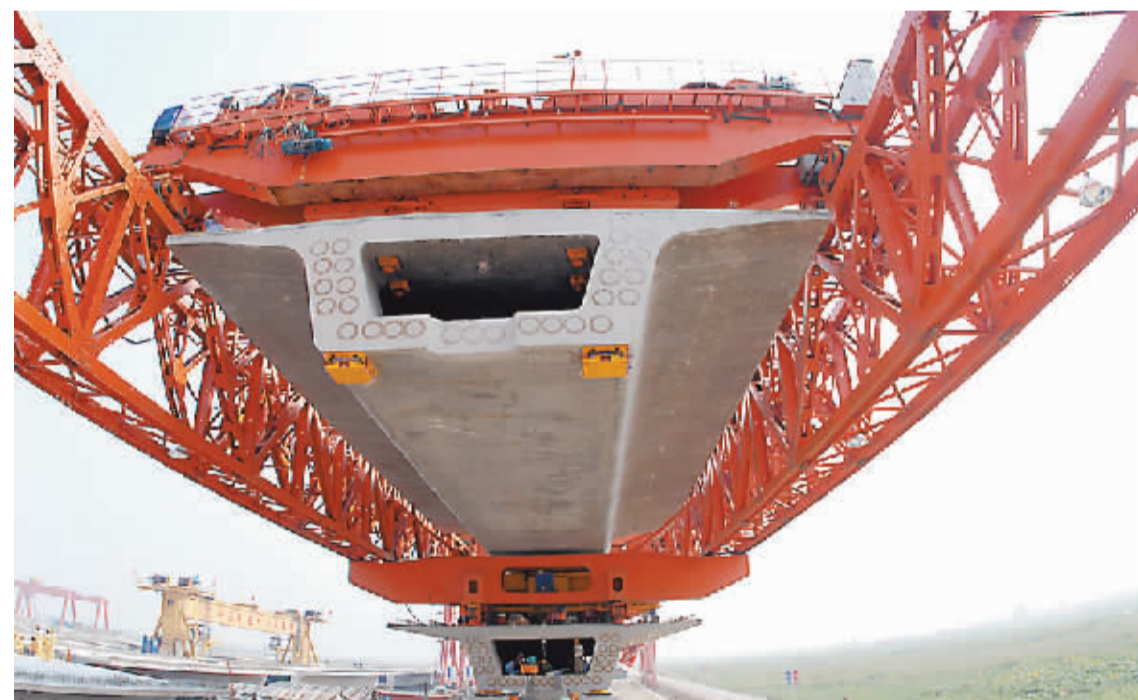
900吨箱梁架设施工
