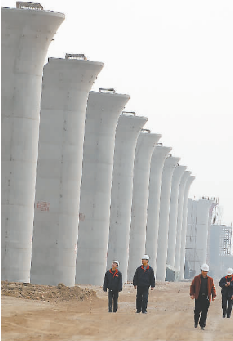
全线“优质样板工程”天津特大桥武清段
