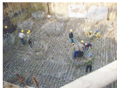
桥墩深基坑施工
