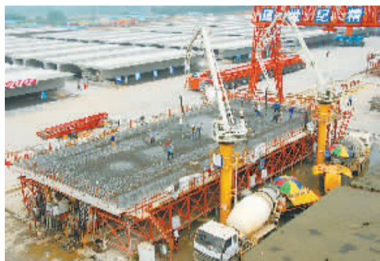
现代化制梁场一角
