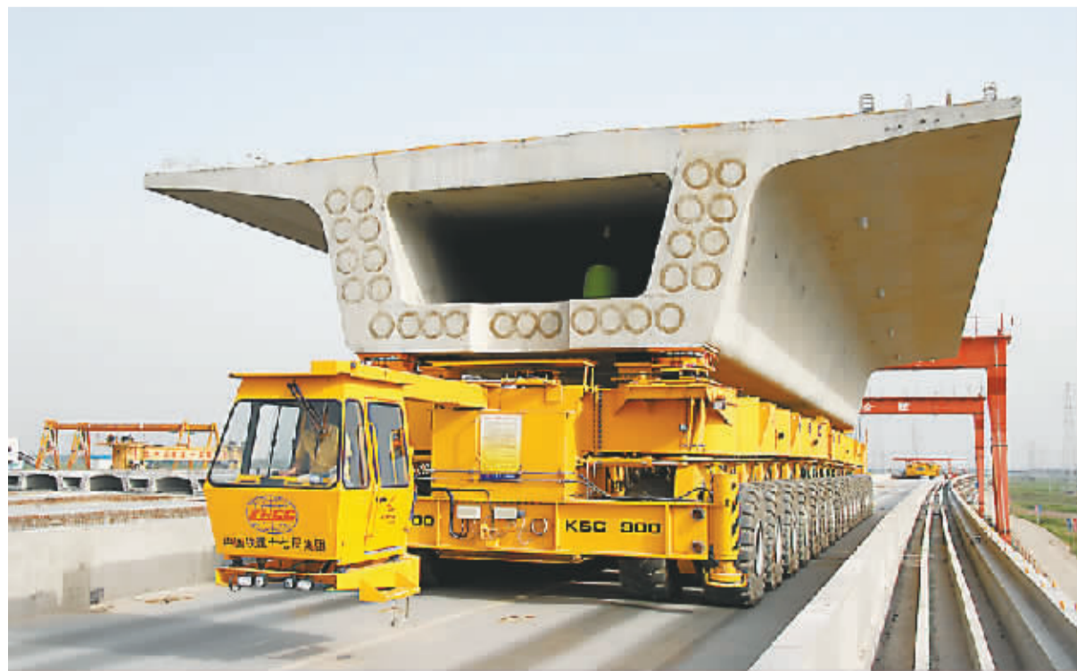
900吨箱梁运输作业
