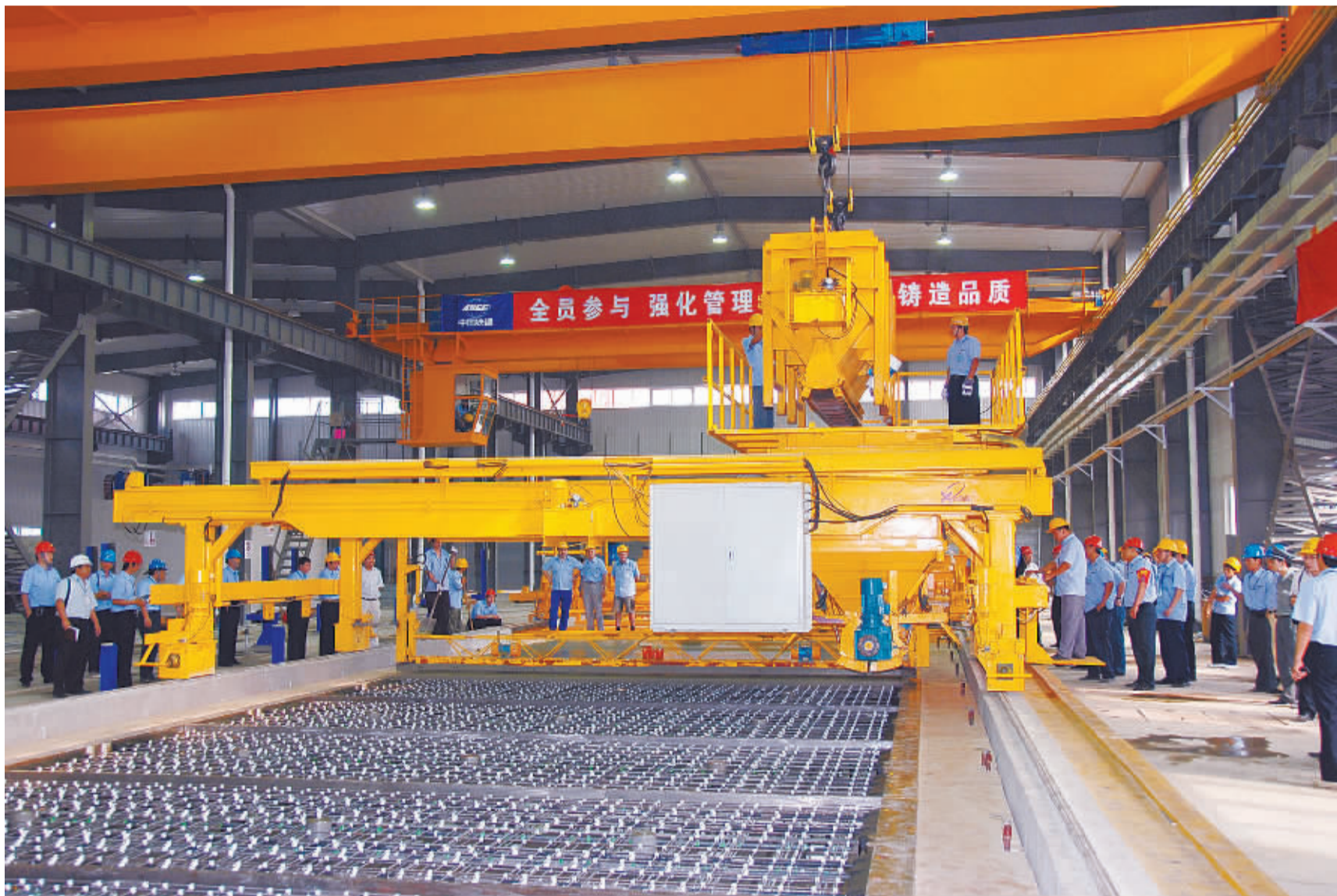
轨道板生产线
