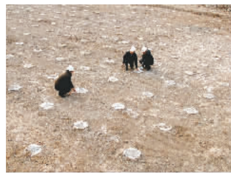
路基CFG桩质量检查
