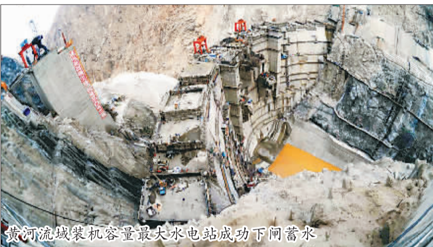
黄河流域装机容量最大水电站成功下闸蓄水 地处黄河上游的拉西瓦水电站(3月1日报)。 当日上午,黄河流域装机容量最大、单机容量最大、水头最高的青海拉西瓦水电站成功下闸蓄水,为保证今年上半年两台机组投产发电打下了坚实基础。 新华社记者 侯德强 摄
