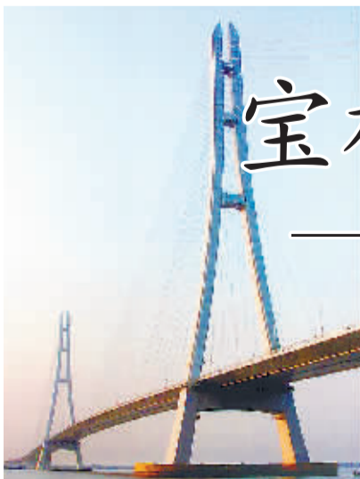
图为中国中铁宝桥制造的被誉为“中国第二塔”、获得国际桥梁奥斯卡大奖“古斯塔夫斯-林德恩斯”奖的南京长江三桥钢塔。
