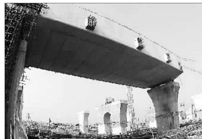
全国首孔直径2600吨特大32米连续箱梁近日在广州新客站建设工程中建成,该箱梁高4.42米,宽13多米。在中铁二十二局集团四公司项目经理陈耀华等领导班子带领下,专家和全体工程技术人员和齐心协力,实现一次性持续浇筑30个小时,创造出我国铁路浇筑新纪录。
