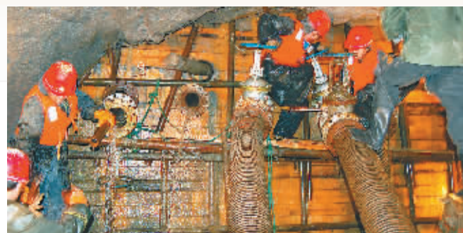
十一局集团五公司职工正在马鹿箐隧道里安装泄水道。
