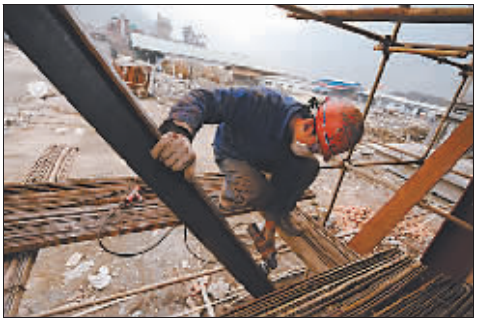
12月28日,地震中全厂设备被毁的什邡市荃锋实业有限公司的职工,正在加班加点重建厂房。
