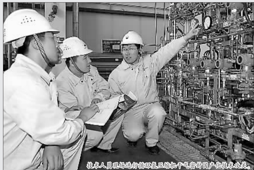
技术人员现场进行循环压缩机气密性国产化技术改造。
