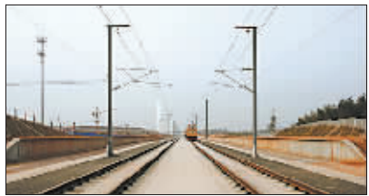
中铁十一局集团一公司在武广客运专线无砟轨道施工中,把无砟轨道道床板施工精度及外观、质量放在工作首位。在集团公司武广指挥部组织的百日大劳动竞赛综合评比中多次获得第一名的好成绩。图为一公司武广项目部施工成型的无砟轨道线路。
