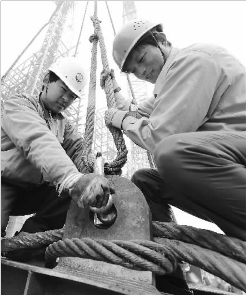
12月2日,两名农民工在天津百万吨乙烯工程工地进行吊装作业。在天津100万吨/年乙烯及配套工程建设现场,有2500多名农民工与中国石化第四建设公司职工一起奋战在10多个大型施工工地。
