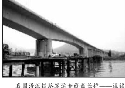
我国沿海铁路客运专线最长桥——温福铁路鳌江特大桥日前提前合龙。全长11,036公里,建筑高度20.5米、由327个墩台组成的鳌江特大桥,经中铁十八局集团二公司建设者3年的科学拼搏,比原计划提前六个月合龙。
