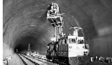
由中铁电化局三公司施工的温福线电气化作业车近日上线施工，标志着温福线上部作业全面铺开，大大加快了整个工程的施工进度。图为电气化作业车正在隧道中安装吊杆。
