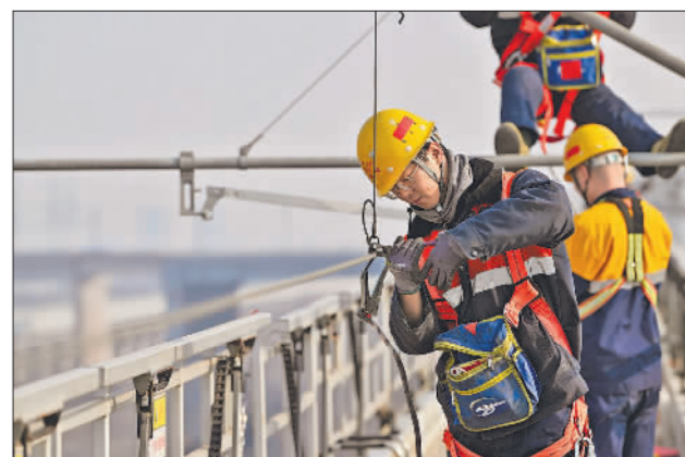
接触网集中修 保障铁路通畅
