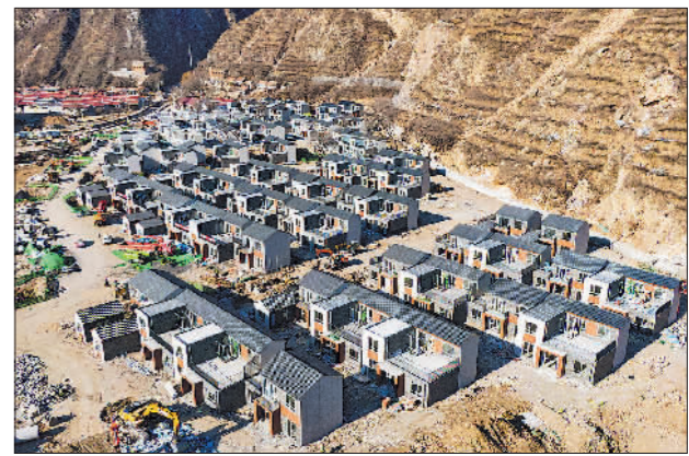
1月16日,门头沟区斋堂镇沿河口村,即将进入内部装修环节的异地安置项目建设现场。
