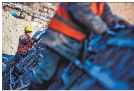
1月3日,房山区,工人正在双泉河修筑堤坝。
