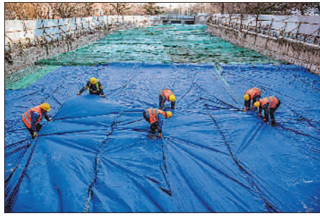
1月3日,房山区东风街道,工人正在修复的河道内给混凝土铺设保温布。
