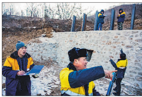
1月15日,门头沟区妙峰山镇,来自中国铁路北京局的单秀松(左二)与同事正在铁路线上进行防洪隐患排查工作。
