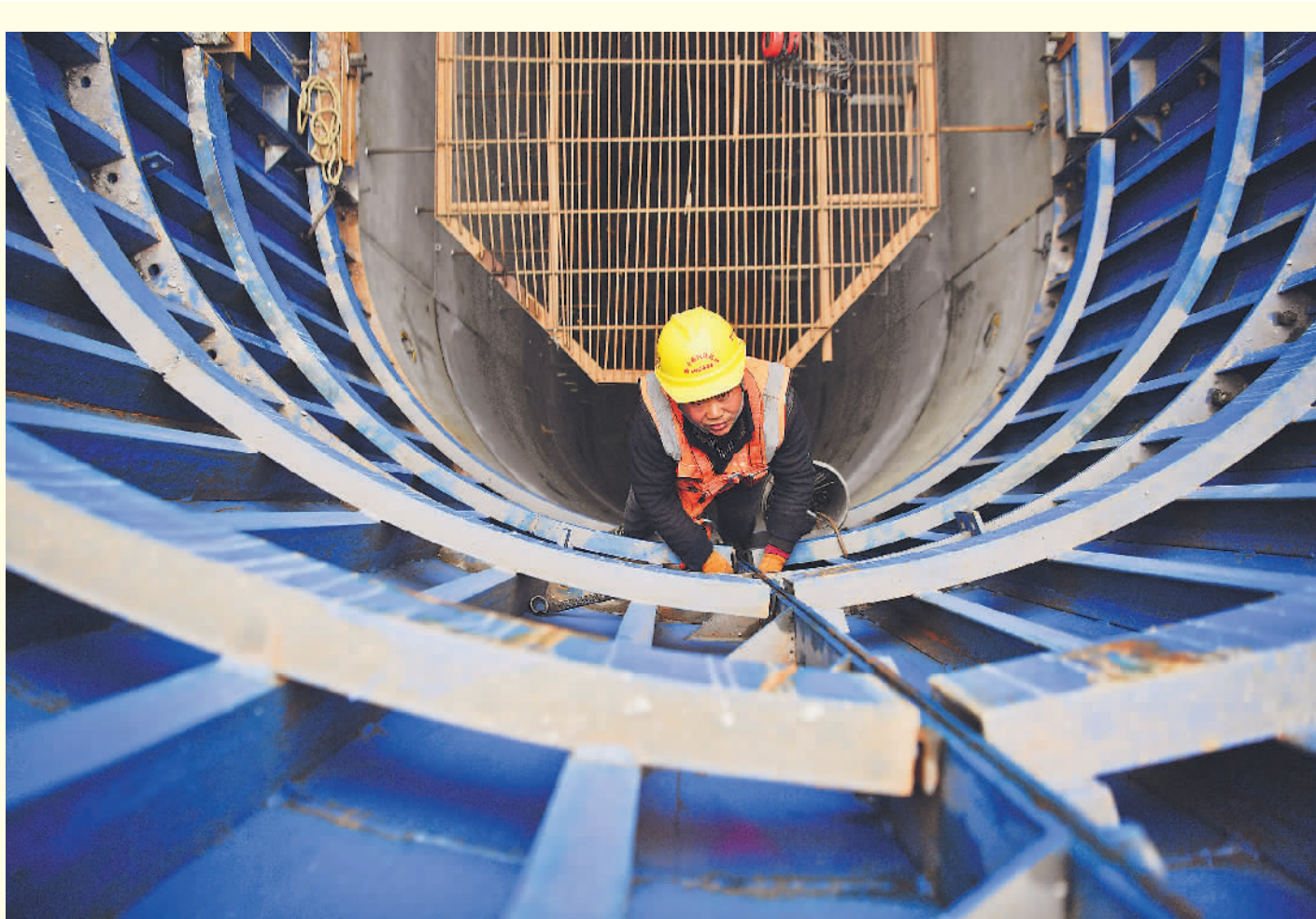
2月7日，中铁二十局工人在位于陕西省商洛市的西十高铁南秦岭特大桥施工现场作业。连日来，位于秦岭地区的西（安）十（堰）高铁陕西商洛段建设正酣。参建单位的建设者们春节过后抢抓工期，保障施工进度。西（安）十（堰）高铁是福（州）银（川）高铁的重要组成部分，西起陕西省西安市，向东南穿越秦岭山脉，终到湖北省十堰市。线路建成后，将与既有（武）汉十（堰）高铁相接，形成西安至武汉快速铁路客运通道。
