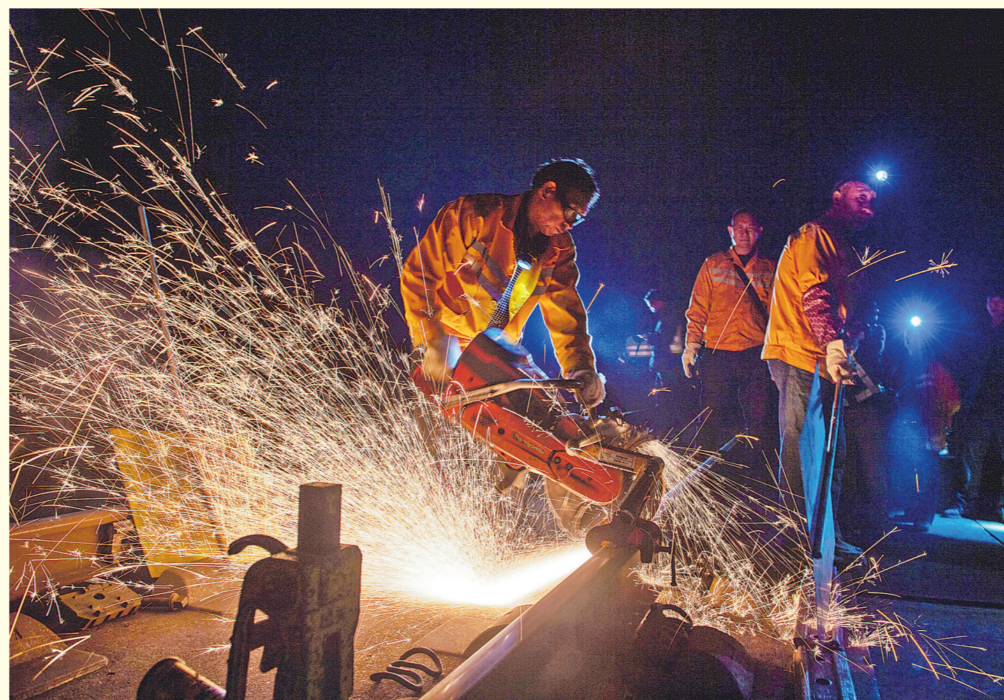
京广高铁换轨施工忙
